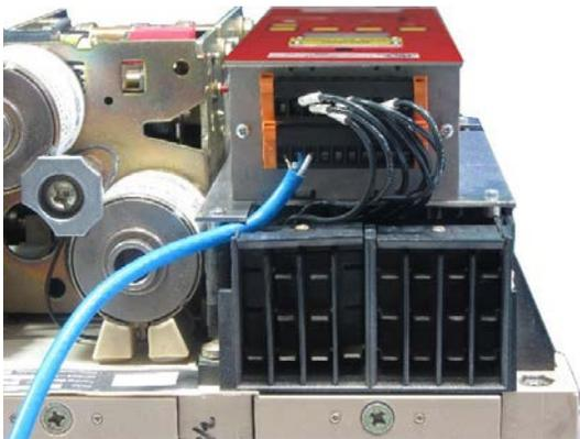
**Installation des câbles de communications (avec couvercle enlevé) (AC-PRO-MP-II)**
