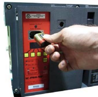
Retirez l'ancienne batterie et installez une nouvelle batterie CR-P2, batterie au lithium à 6 volts. Remplacez le couvercle de la batterie.
